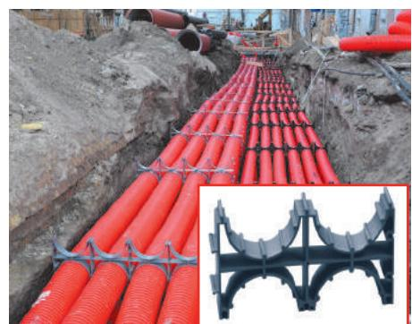
Рис.1 Применение кластеров для многоуровневой кабельной канализации.
